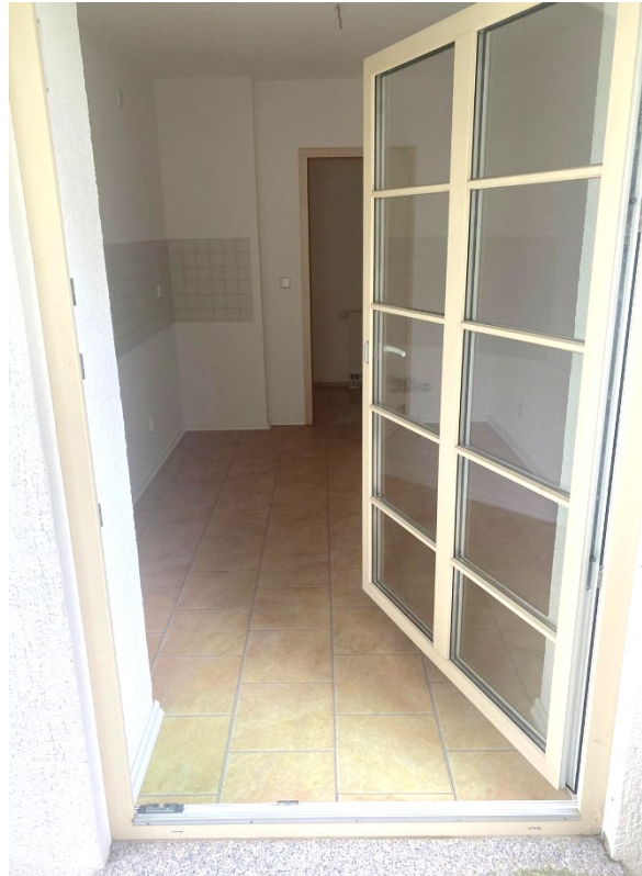
Austritt zum Balkon
